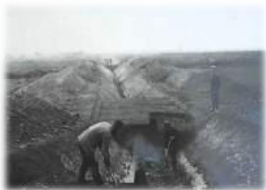
Копка магистрального канала, 1937 г.
